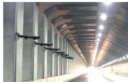
Installation des PEC Kabelhaltersystems im Tunnel
